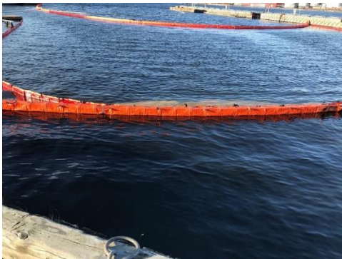
Bild 3: Oljelänsar utlagda för att stänga in oljeutsläppet
